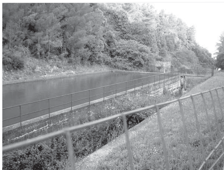
Acquedotti rurali, irrigazione, valorizzazione delle sorgenti naturali
